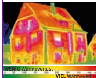
Eine Thermografie-Aufnahme zeigt mit den Rot- und Gelbtönen schockierend, wie am ungedämmten Haus die Wärmeverluste am größten sind. Hier wird es höchste Zeit, etwas zu unternehmen.
