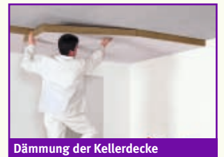
Dämmung der Kellerdecke
