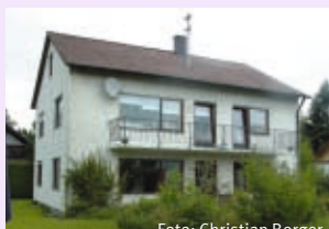
ALT: hohe Energieverluste ohne Dämmung
