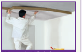
Dämmung der Kellerdecke
